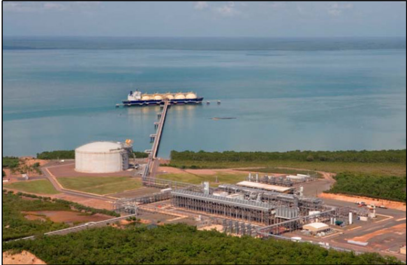
ConocoPhillips' Darwin LNG Plant
